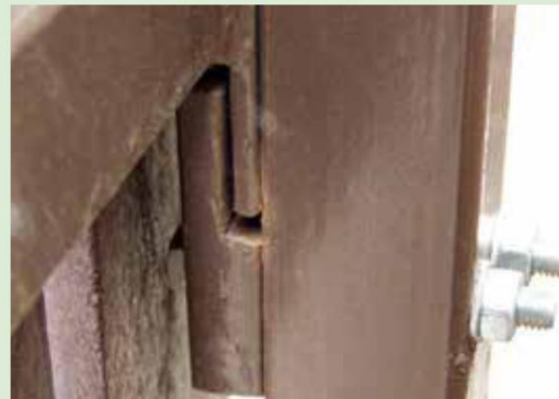
Detail úchytky s fixačním šroubem
